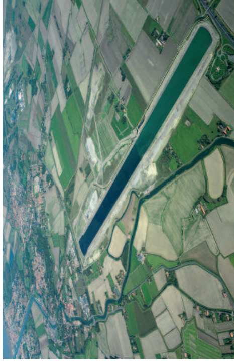
Gravelines, vue de l'aide nautique et de la ville fortifiée en arrière-plan © Ville de Gravelines
